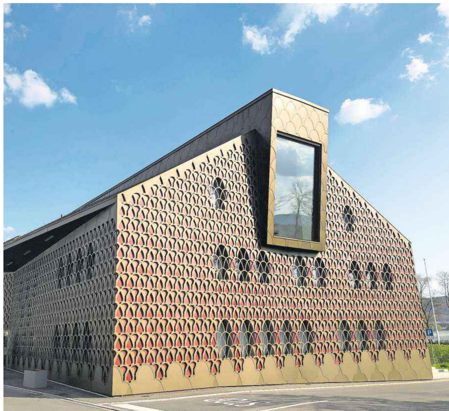
Hinter dem grossen Fenster liegt sein Sitzungszimmer: Neu kann der Gemeinderat häufiger kleinere Entscheide in Eigenregie fällen. Bild: fto
