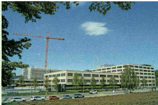
Im 14-stöckigen Hochhaus wirkte Chefarzt Basil Caduff dreissig Jahre. Im Oktober wird der Bau abgerissen sein – Foto vom 18. August 2019
