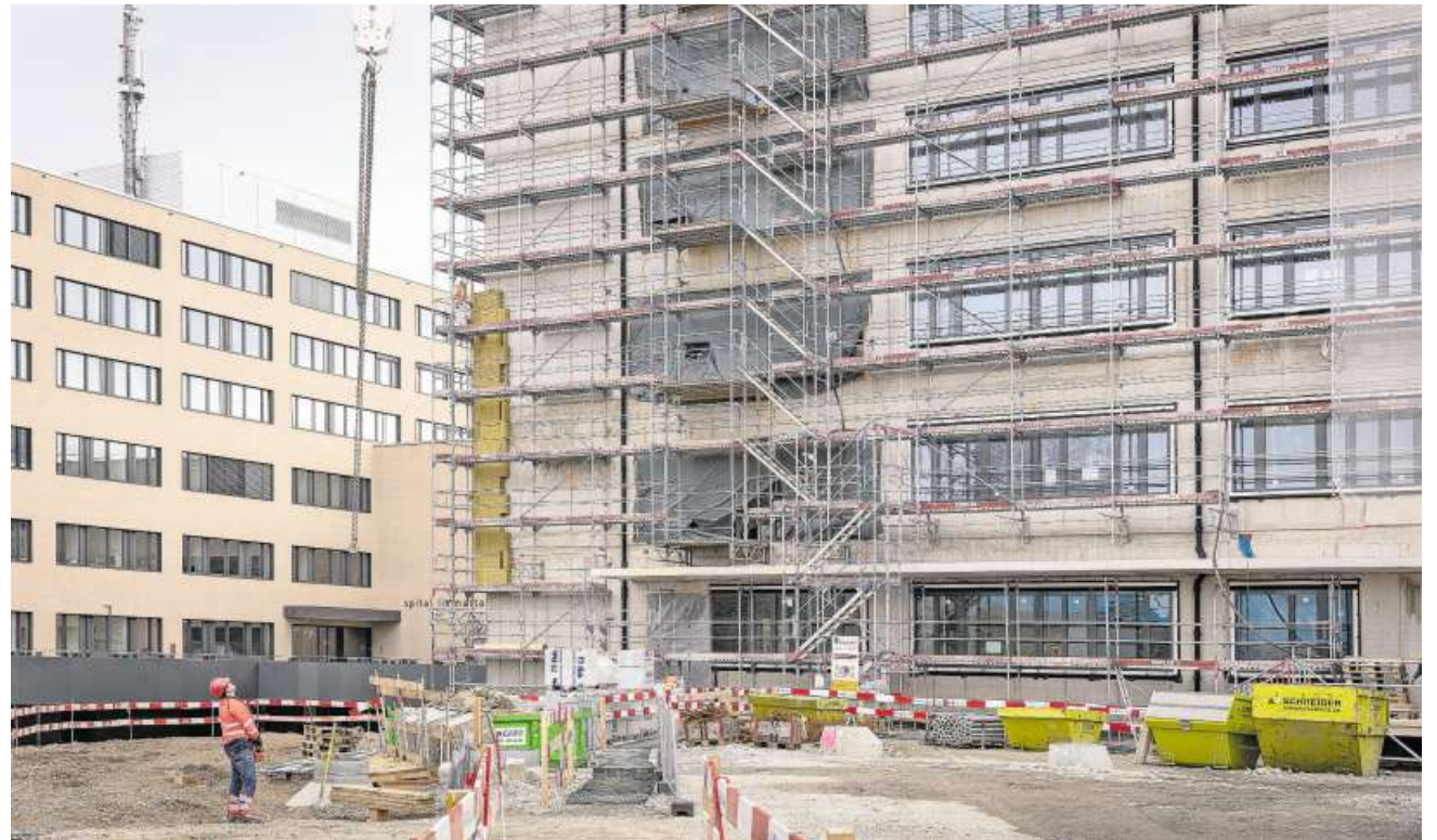
Das 16 000 Quadratmeter grosse Pflegezentrum bietet Raum für 73 Einzel- und 42 Zweierzimmer.
