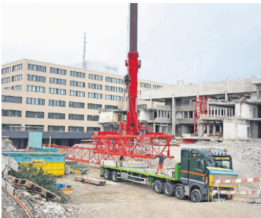
Die letzten Teile des Turmkranes verlassen mit einem Tieflader die Baustelle.
