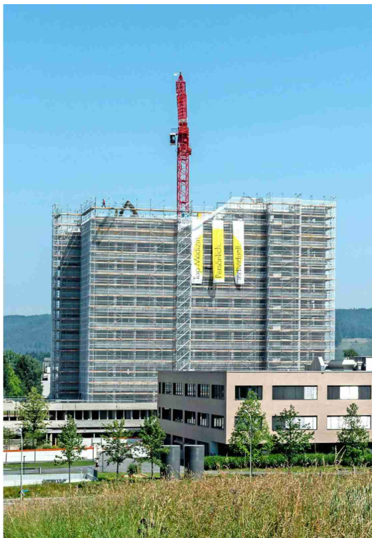
Zwei Geschosse sind bereits weg: Das Spital Limmattal.
