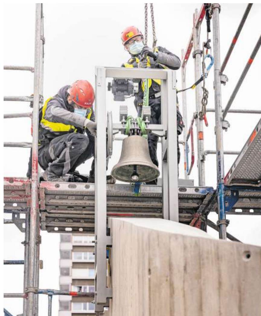
Die 40 Kilogramm schwere Glocke ist nun im Glockenturm befestigt. Bild: Chris Iseli
