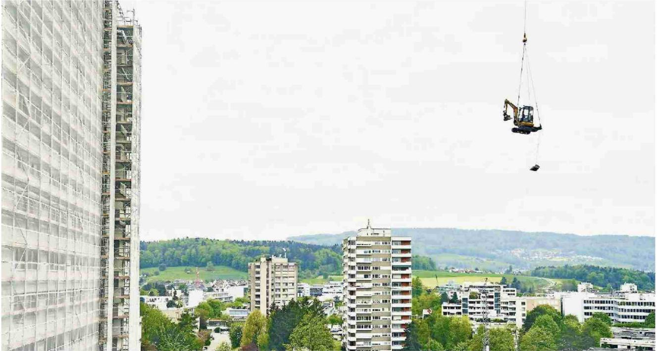
Das Ende des grossen Spitalgebäudes beginnt mit einem kleinen Bagger: Dieser läutet vom Dach aus den Abbruch des 15-geschossigen Hochhauses ein.
